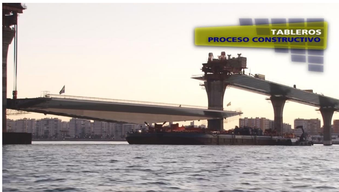
Traslado, izado y montaje del puente desmontable
