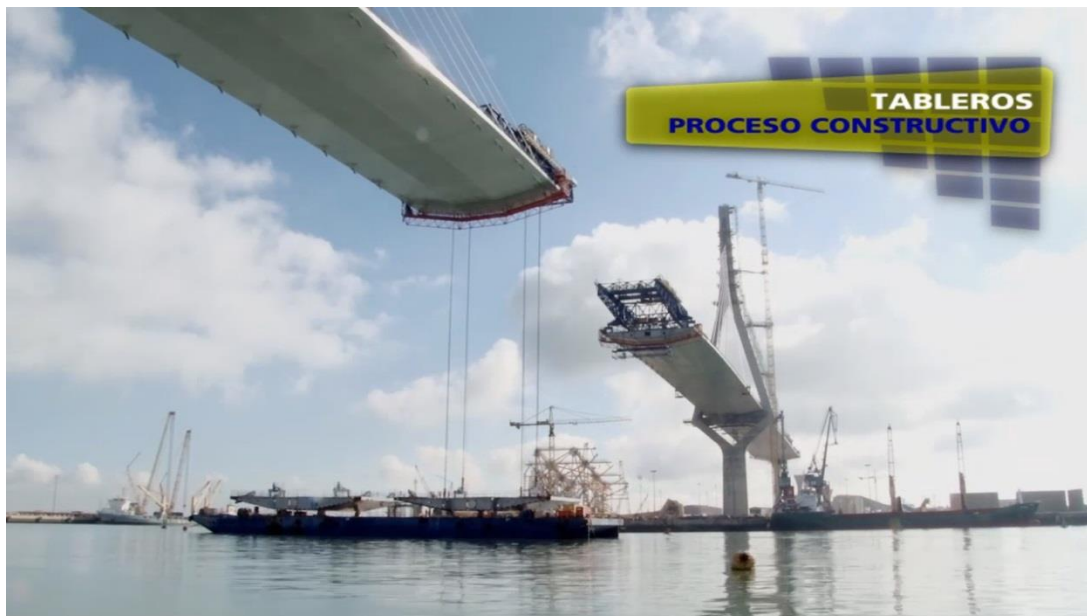
Cierre del vano central del puente
