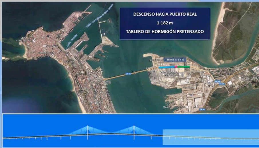
Puente de la Constitución de 1812
