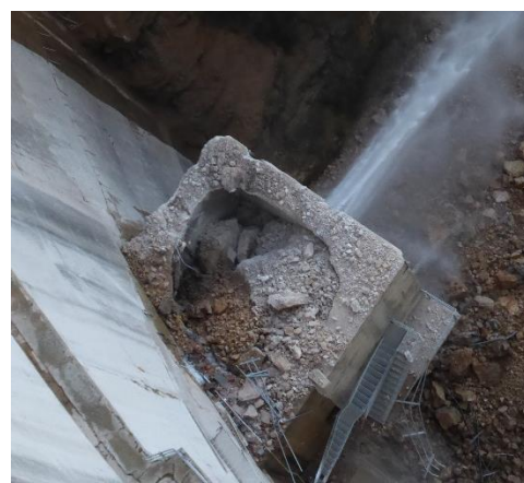
Cuña deslizada, ya identificada en el levantamiento geomecánico 2017.
