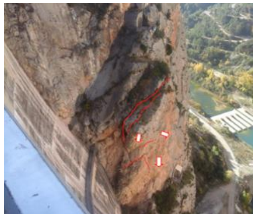
Cuña deslizada, ya identificada en el levantamiento geomecánico 2017.
