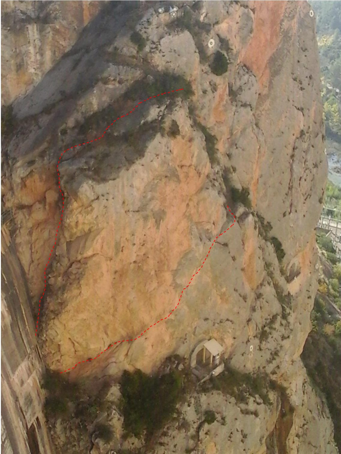
ESTADO 16/11/2016. LAS LÍNEAS ROJAS RESIGUEN LA ZONA DEL BLOQUE DESPRENDIDO EL 27/11/2018.
